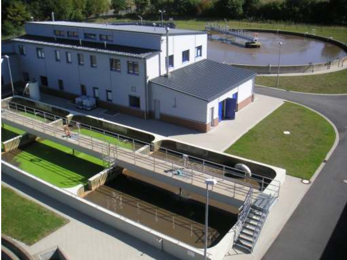
Misch- und Ausgleichsbecken (vorn) und Belebungsbecken (hinten)
