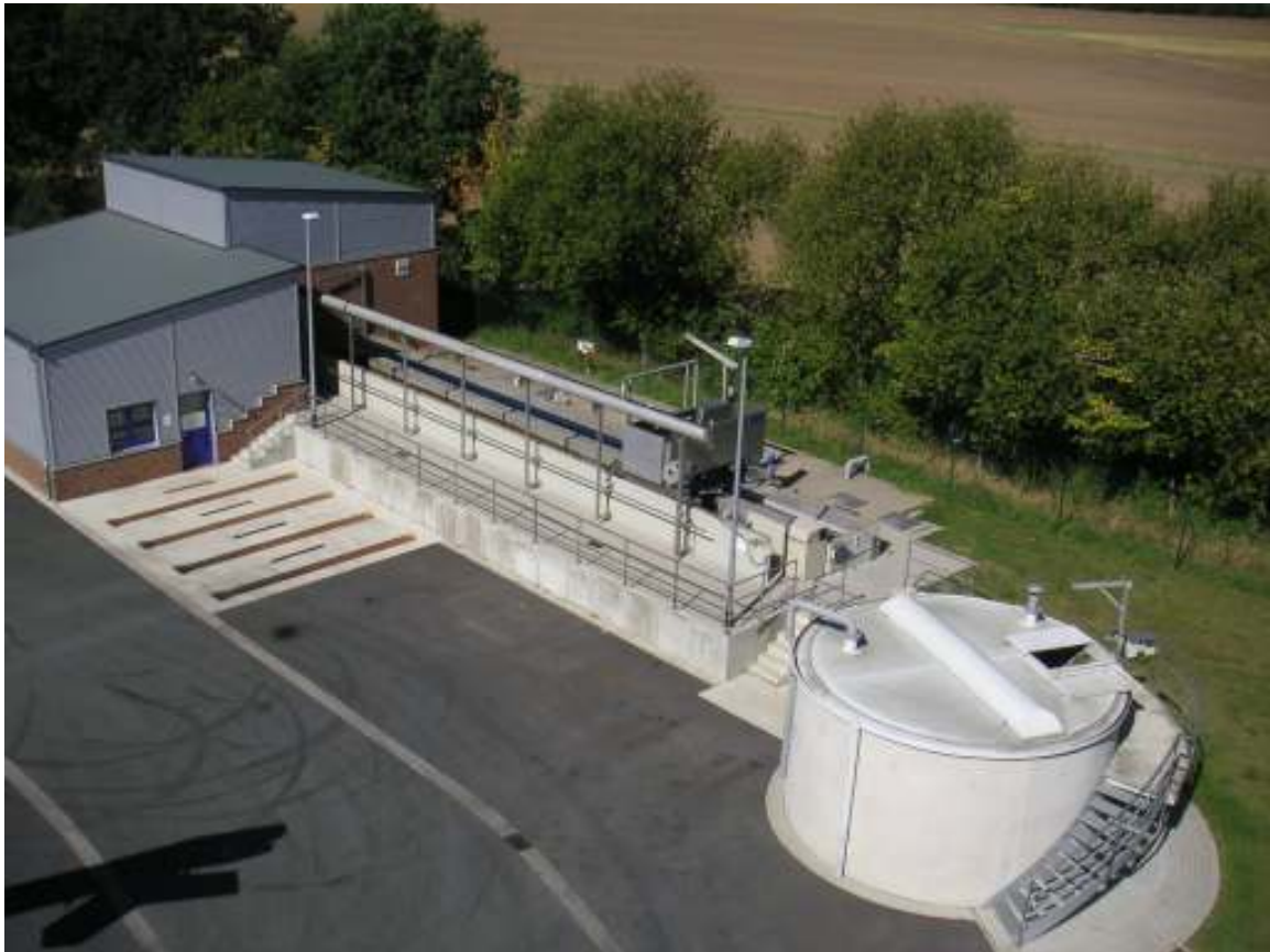
Mechanische Reinigung mit Rechenwerk (links) sowie Öl- und Sandabscheider (Mitte)
